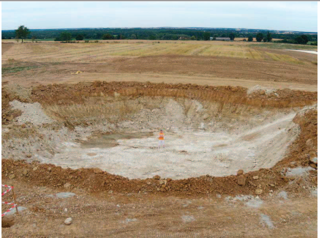
Photo 2 : Création des fouilles de fondations de 18 mètres de diamètre sur 3 m de profondeur, nécessaire à la mise en place d'une éolienne, soit environ 800 m 3 .
